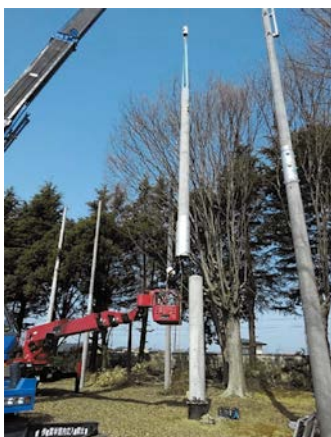
下柱施工完了、上柱建て込み
