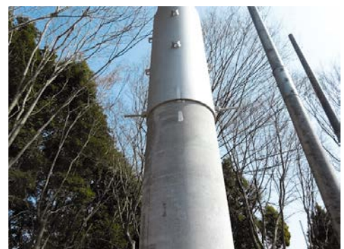
上柱の挿入、施工完了
