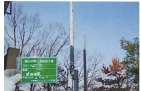
上柱と下柱の継柱状況 (建柱して行う場合)
