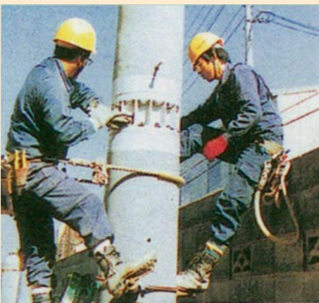
建込み継柱施工
